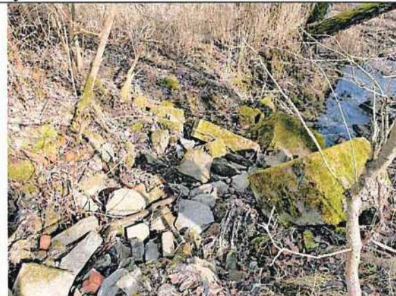
Foto č. 6 – nevhodný materiál na vzdušní straně hráze Horního cihelenského rybníku
